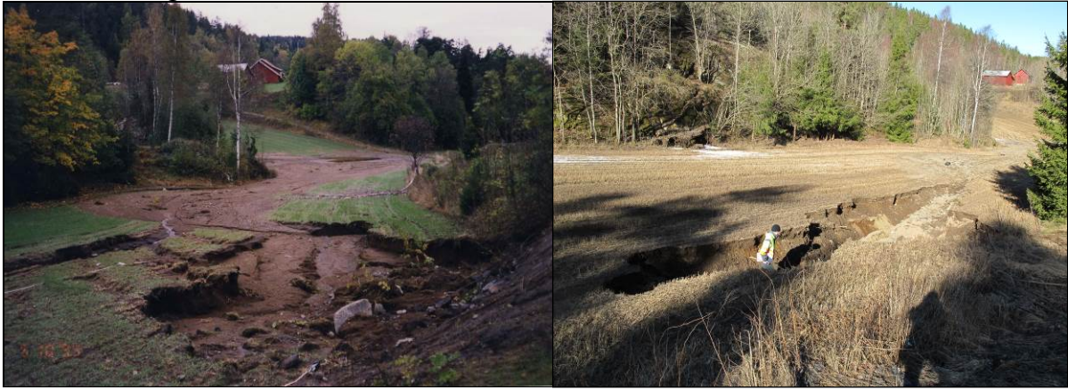
Figur 11: T.v. skadene påført Tusseboplassen i 1999. Skadene er forårsaket av vann fra veilegemet. Bildet er tatt mot nord. Foto: Lil Gustafson, KHM. T.h. skadene påført Tusseboplassen i 2014. Situasjonen minner mye om den i 1999, men rennen har en noe annen form og retning. Bildet er tatt mot nord. Foto: Carine Eymundsson, KHM.
