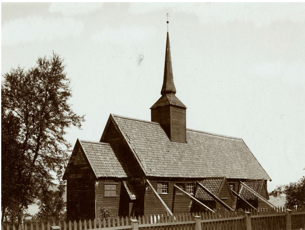
Ill. 5 Kvernes stavkirke, ca. 1900, avstivet med utvendige skorder. I dag er det bare Kvernes og Rødven kirker som har slike støtter. Foto: C. Christensen Thomhav. Riksantikvaren.
