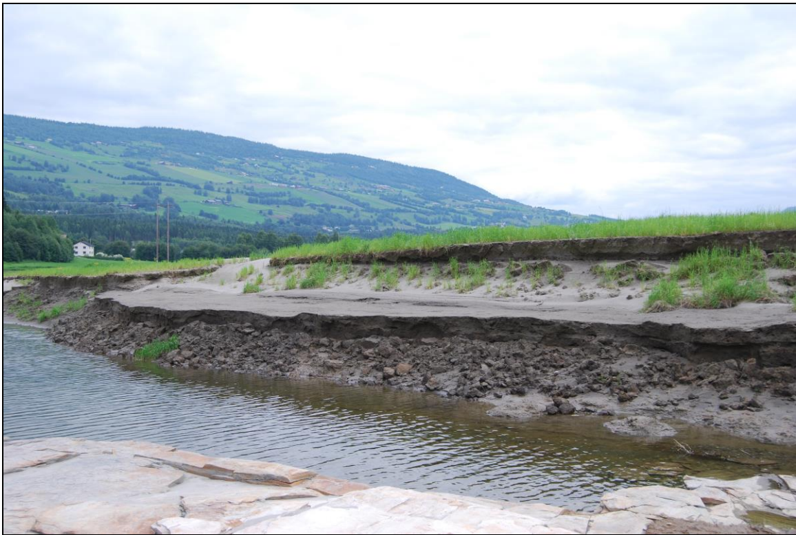
Figur 5: Erosjonskanten på Gryttingvollen etter Pinseflommen i 2011. Foto: Ingar M. Gundersen (Cf.34494_15).
