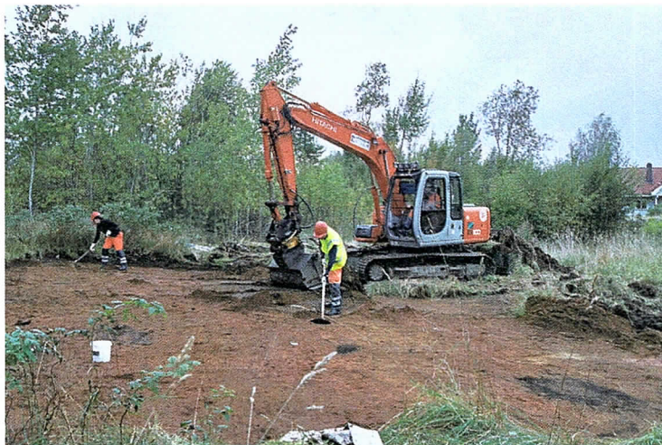
Fig 1: Opprensing med krafse ved maskinell flateavdekking.
