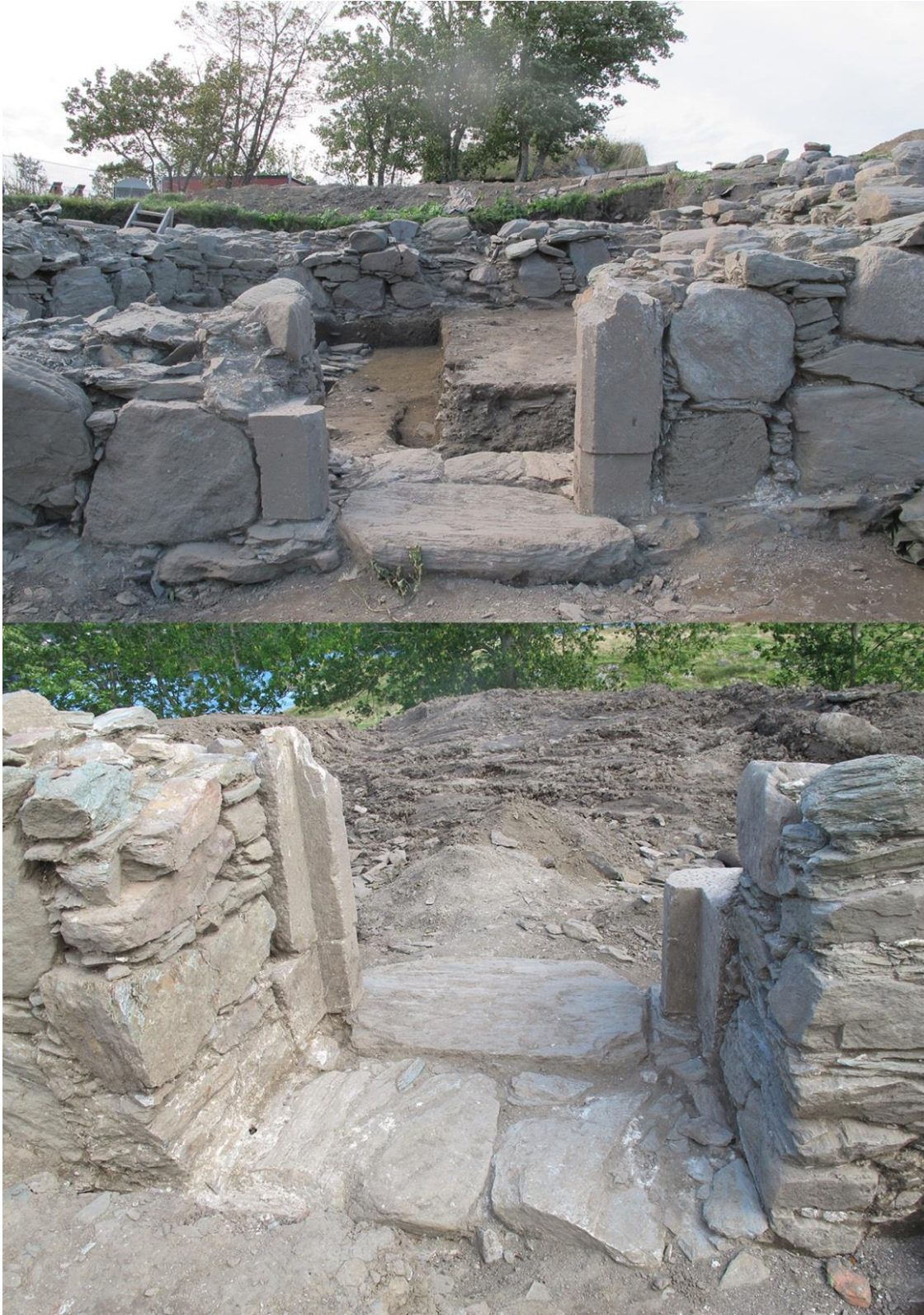
Figur 29 Døråpningen i underetasjens østmur. Åpningen på bildet øverst måler 1,28 m, mens det mellom anslagene på det nederste bildet er 1,53 m. Anslagene viser også at døren har slått innover (Foto: Erlend Nordlie, hhv. Sf154852 og 51)
