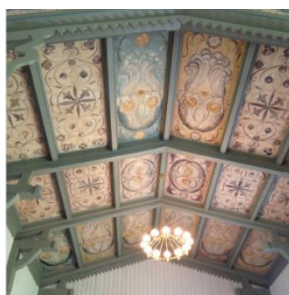
Taket i koret
