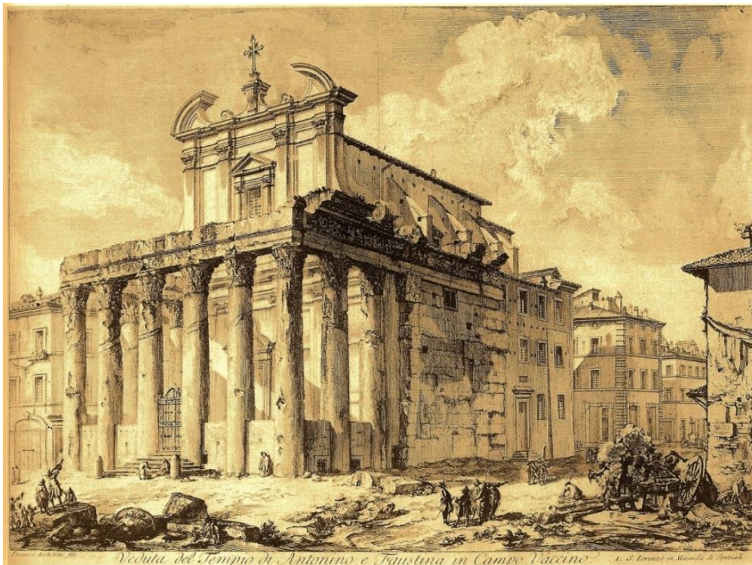
Fig. 17: San Lorenzo in Miranda slik den fremstod før arkeologenes inntog på 1800-tallet. Muren som ble reist mellom søylene ved konverteringen til kirke er synlig. Det samme er kuttene i øvre delen av søylene (Piranesi, 1758).
