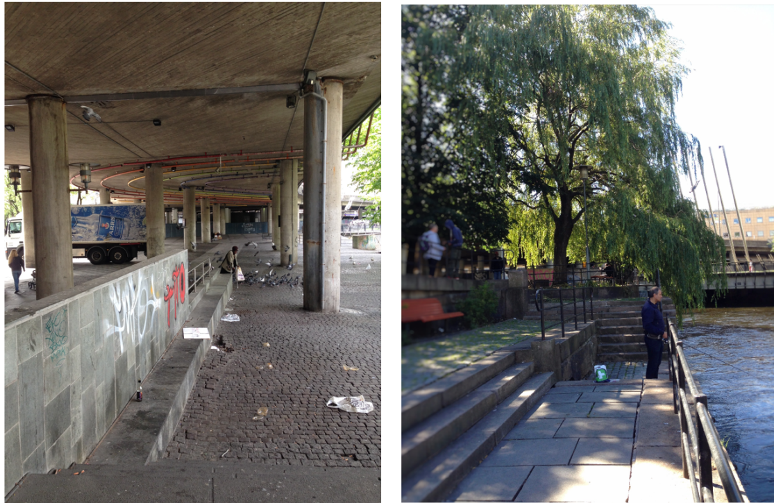
Figur 2: T.v.: Olafiagangen under Nylandsveien. T.h.: Fiskebryggene i Olafiagangen. Fiske i Akerselva og kjøp og salg av rusmidler
