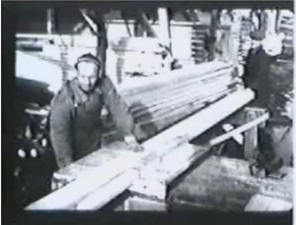
I revy nr. 13/1948/02 «Montering av ferdighus for Finnmark» viste Filmavisa menn i arbeid på Sørenga som dømte på korleis ein rundt om i heile landet var med på å gjenreise Finnmark.
