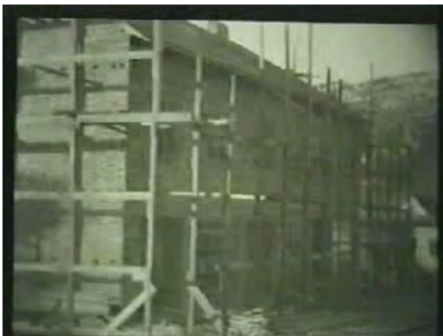
Bygging av «svenskehus» i Åndalsnes (revy nr 08/1946/01)
