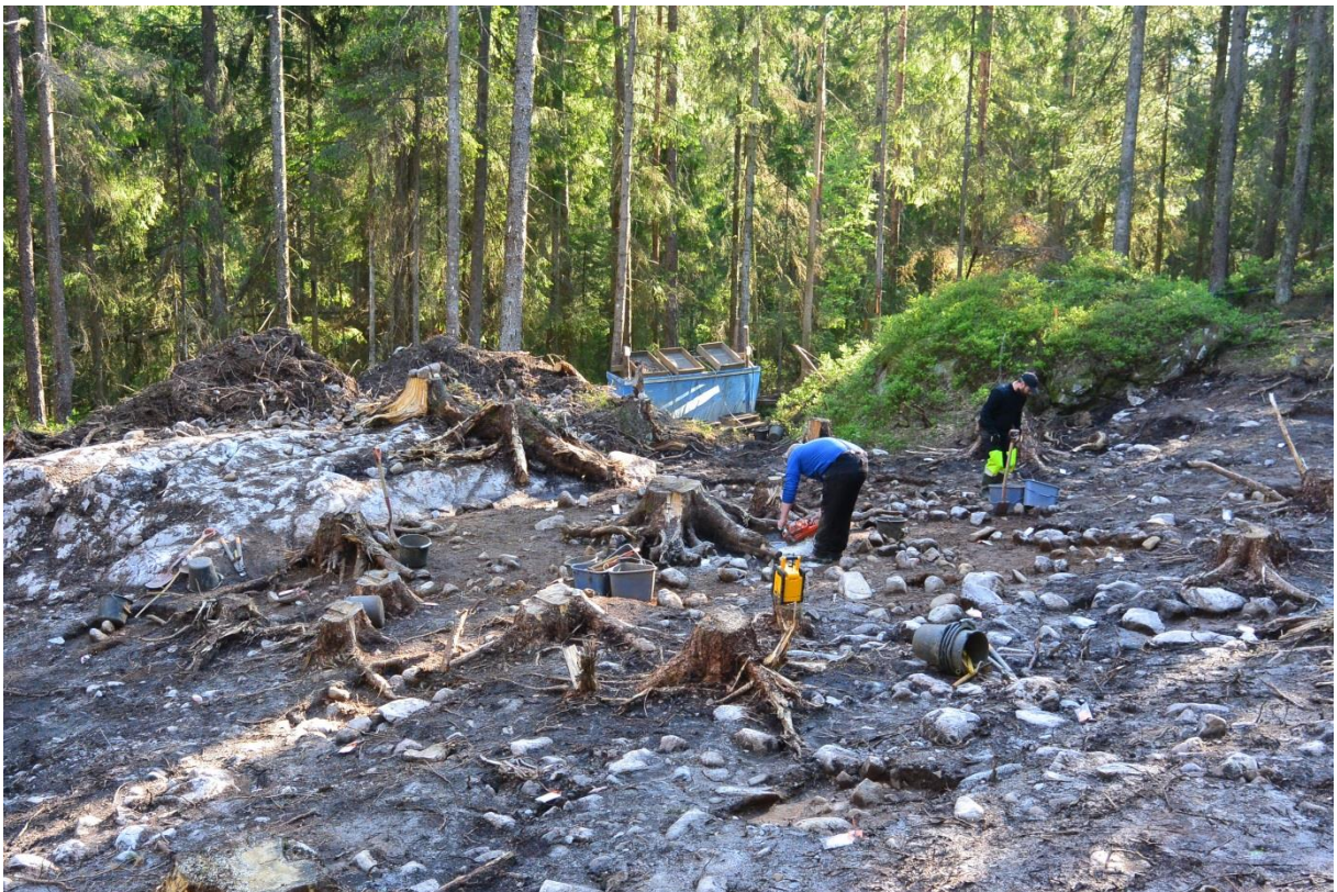
Figur 5 Tinderholt 1 under utgravningen. Som bildet viser var den mye stein i undergrunnen.
