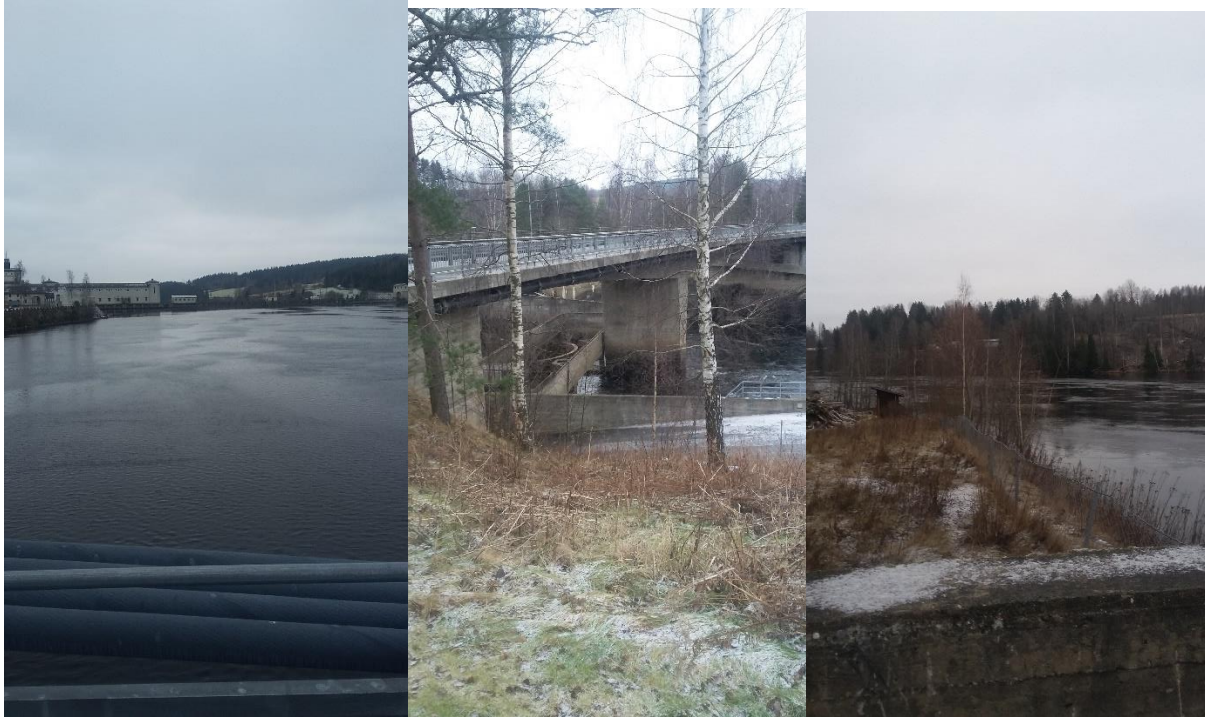
Figur 19: Bildet til venstre er tatt fra broen overfor Braskereidfoss, og viser at elvebredden er utbygd og planert i flere kilometers lengde. De to bildene til høyre viser Bingsfossen. Tunge betongkonstruksjoner i området rundt strykene, og planerte og parkmessig anlagte elvebredder ovenfor og nedenfor kraftverket.
