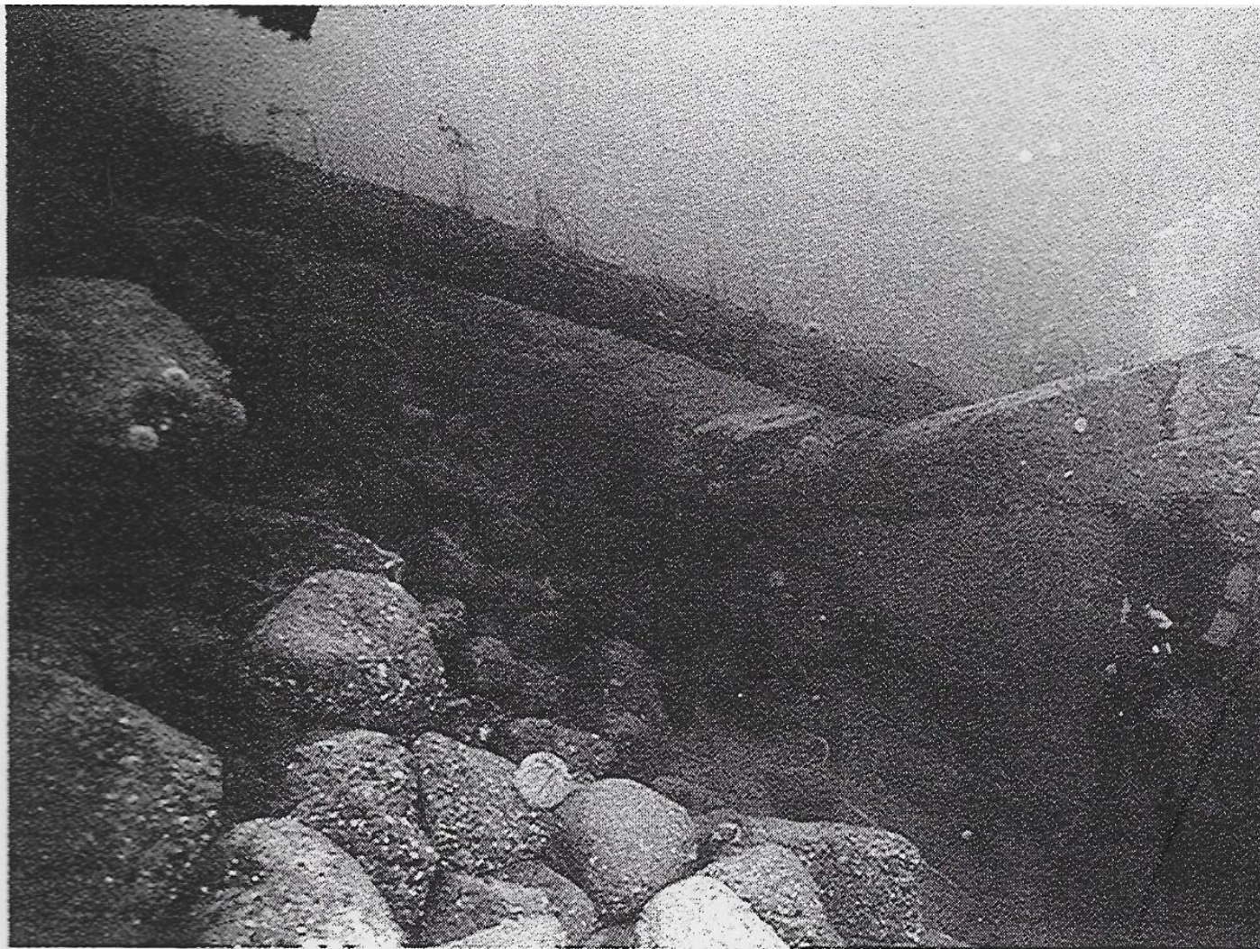
Fig 5: Tømmeret ved bryggekonstruksjonene i Kong Øysteins Havn. Havneanlegget er sannsynligvis bygget 1108 – 1111
