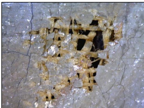
E Detalj av hull 5 før riftreparasjon
