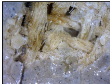
D Detalj av hull 6 før konsolidering av oppskallinger
