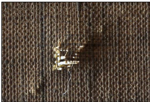
C Detalj av hull 5 før planering (bakside)
