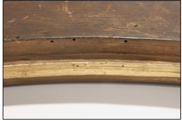
Tidligere spikerhull. Blindrammen var nok festet med spikre i pynterammen som var bøyd over blindrammen
