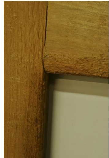
III.30 Den indre rektangulære kanten var filt til
