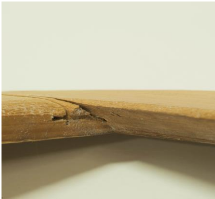
III.28 Detalj av sammenføring: bladskjøte, og spor fra produksjonen, håndsagede lister og
