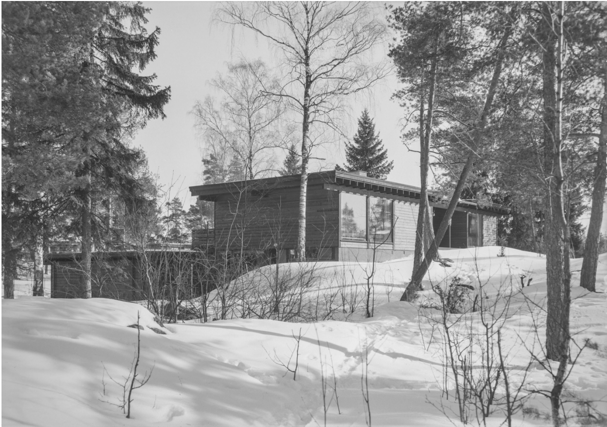
Fig. 16. Molle og Per Cappelen. Enebolig for Lindboe (1960). Vindusflater inn mot hagearealet i vest. Fotograf: Teigens Fotoatelier. Datering: 1962. Eier: Norsk Teknisk Museum.
