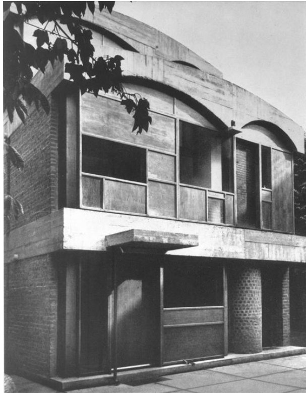
Fig. 82. Le Corbusier. Maisons Jaoul (1955). Fasade. Fotograf og datering: ukjent. Eier: Fondation Le Corbusier.
