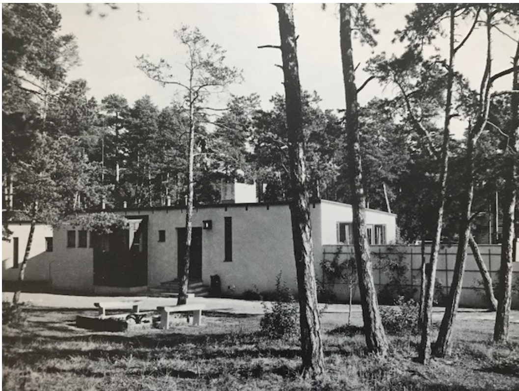
Fig. 63. Knut Knutsen. Enebolig for Engebretsen (1960). Vestfasaden. Datering: ukjent. Fotograf: Teigen Fotoatelier. Eier: Norsk Teknisk Museum.
