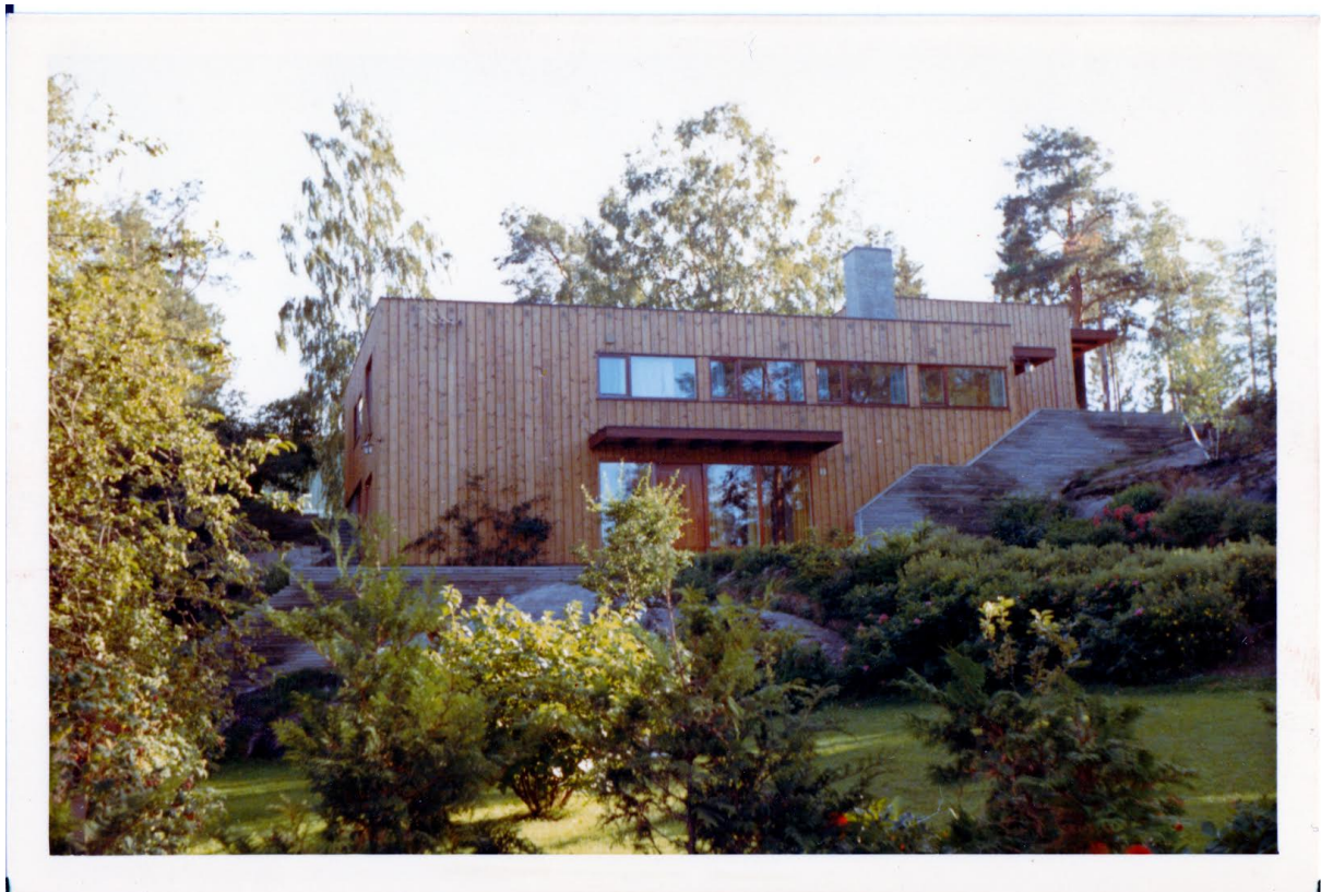
Fig. 38. Wenche Selmer. Enebolig for Hellen (1964). Inngangsfasaden i nord. En steintrapp løper på tvers foran fasaden helt fra øst til vest. Fotograf og datering: ukjent. Eier: privat.
