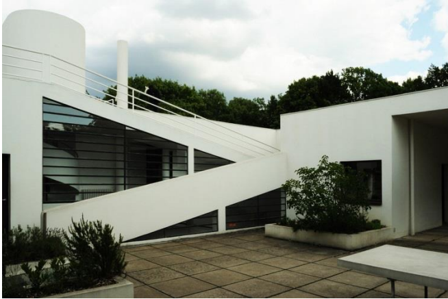
Figur 44: Le Corbusier, Villa Savoye, fasade med rampe. 1928-1931.
