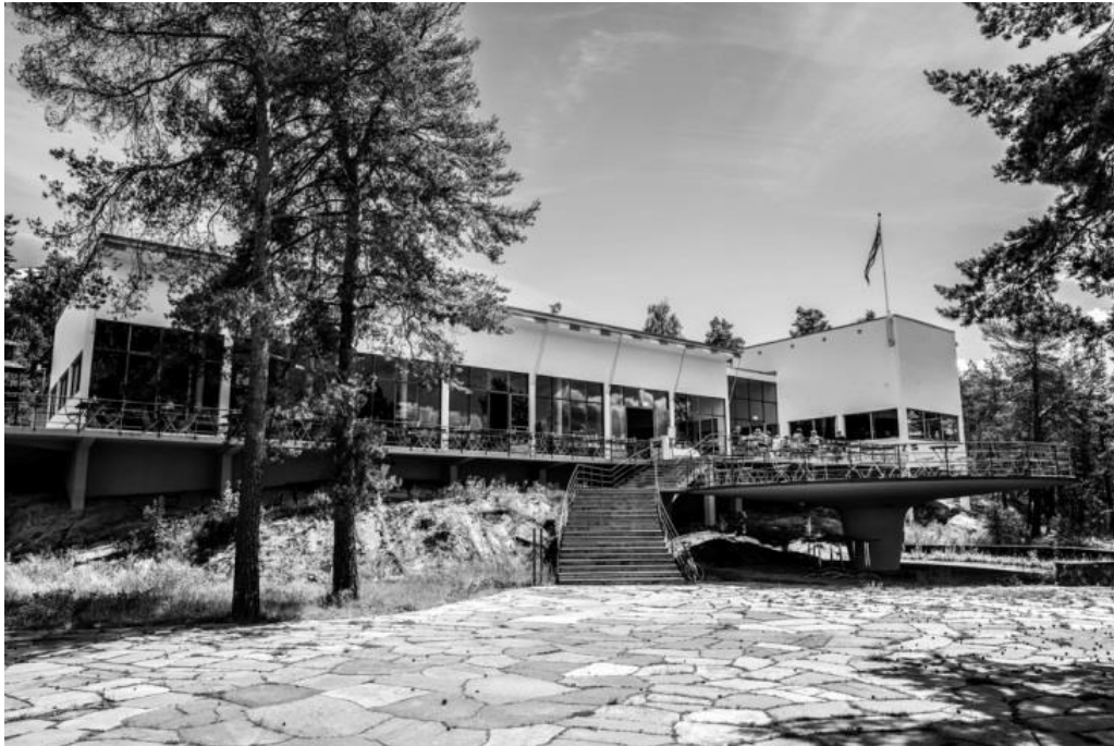
Figur 27: Ole Lund Schistad og Eyvind Moestue, Restauranten på Ingierstrand bad, 1931-1934. FOTO: http://www.ingierstrandbad.no/
