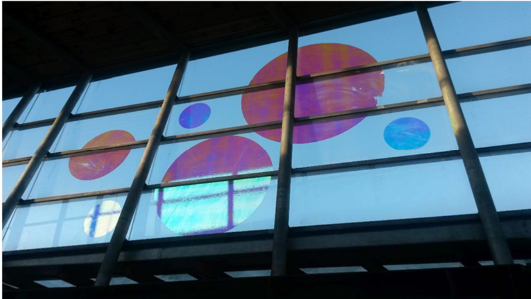
Fig. 4.1 Sinsen T, trapphusets fasade mot perrongen Privat foto: tatt 09.12.15 Sirklene er dekorative innskudd på glasset
