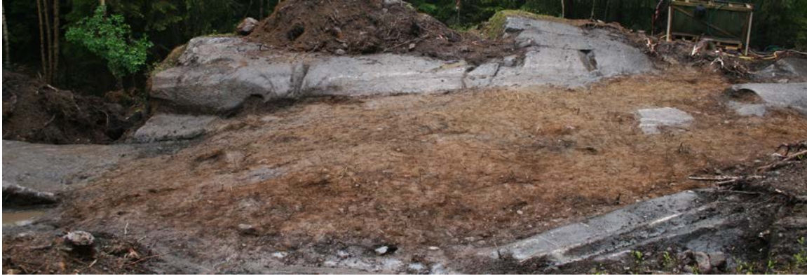
Figur 13: Oversikt over lokaliteten etter maskinell flateavdekking. Bilde tatt mot nordvest (Cf34779_5565). Foto: Jo-Simon F. Stokke
