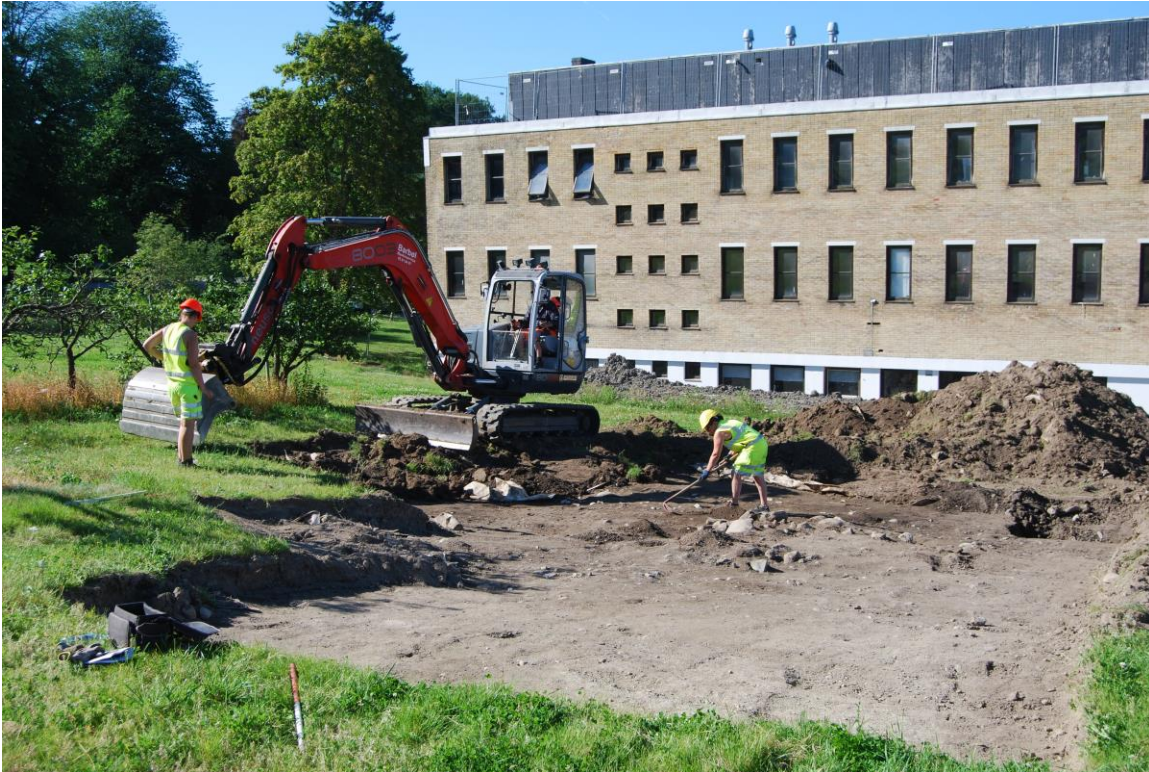
Fig. 4: Avdekking ved id 146384. Retning sør (Cf34744_009.JPG). Foto: Jessica Leigh McGraw.
