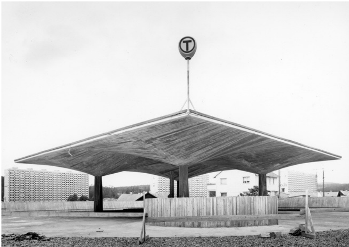
Figur 07: Det utkragede skjermtaket over stasjonshuset. Fotografiet er tatt fra østsiden av
