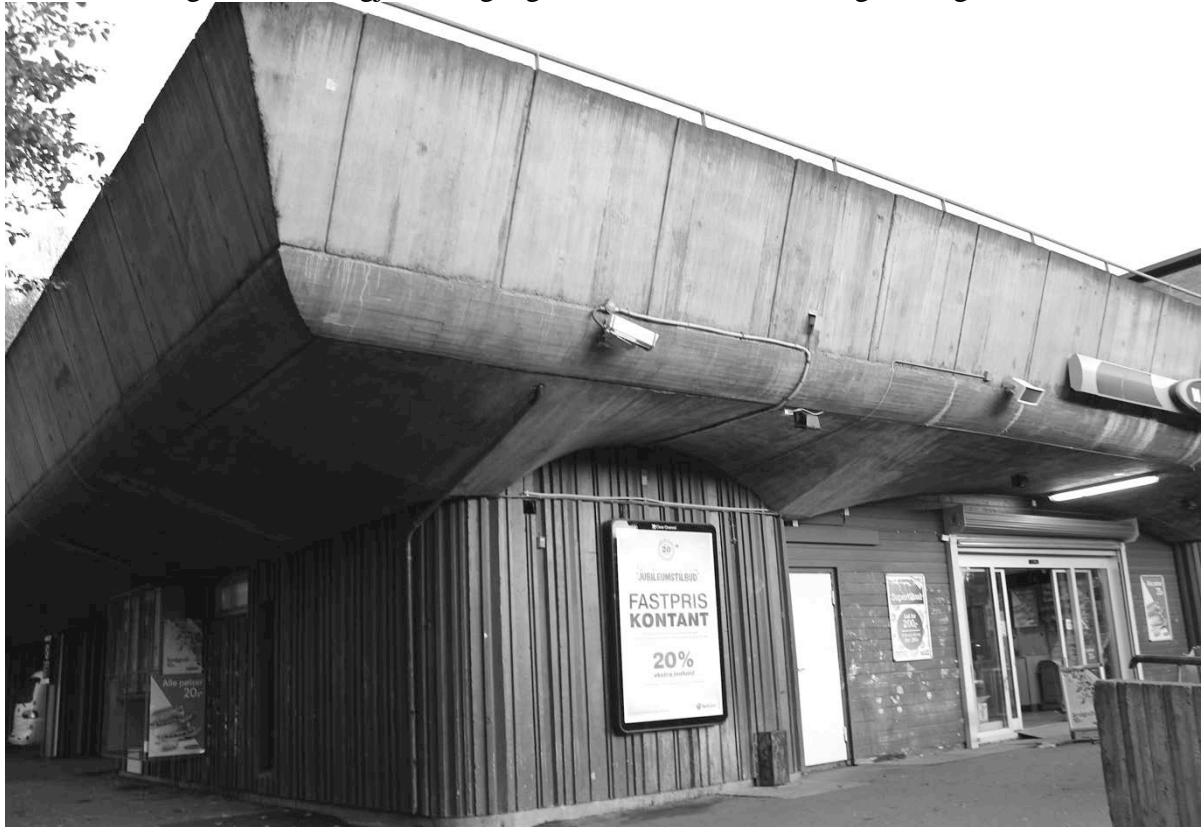
Figur 06: Avslutningen på stasjonstaket, fremspringende over stasjonen og med en oppsvinget vipp. Legg merke til moduleringen av formen.
