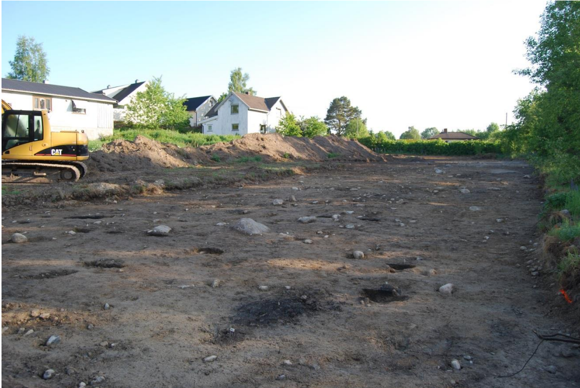
Figur 4. Cf34776-1-60. Under avbaningen. Sett mot N.
