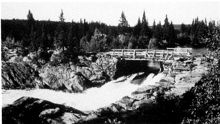
Bilde 1. Parti fra utløpsosen i Dokkfløyvatnet med deler av tømmerfløtningsanlegget.
