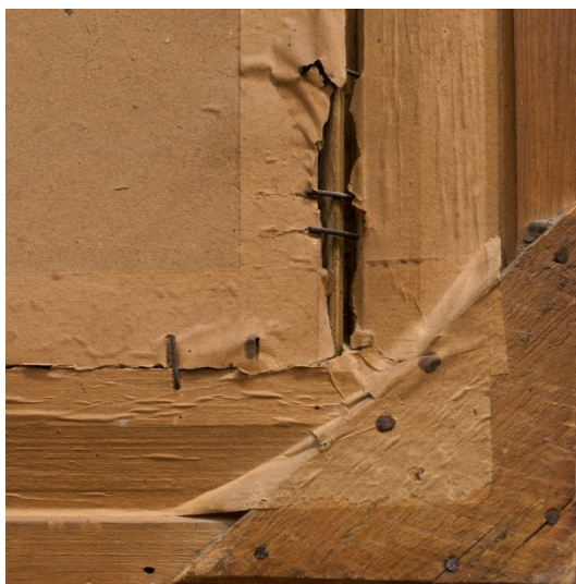
Fig. 54. Monteringen i den sekundære pynterammen var ikke tilfredsstillende.
