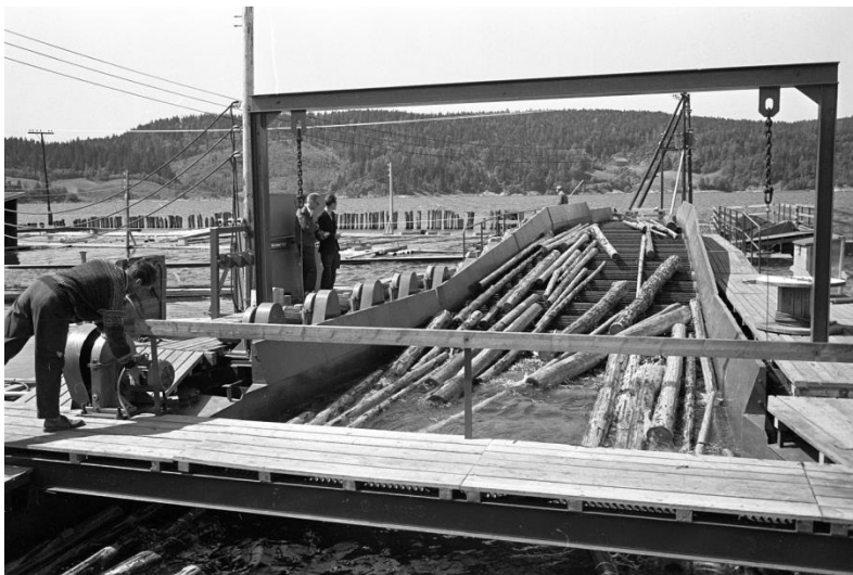
Fetsund lenser gjennomgikk store forandringer i 1960-årene. I 1969 kom et mekanisk retteanlegg som erstattet det manuelle arbeidet med å rette inn tømmeret på vei ned til Soppemaskinene. Retteanleggene ble bygd på Glennetangen lenser, hvor dette bildet ble tatt. Her var de i bruk fra 1962-63. Et av disse anleggene ble flyttet til Fetsund lenser i 1969. (foto: Johan Brun)
