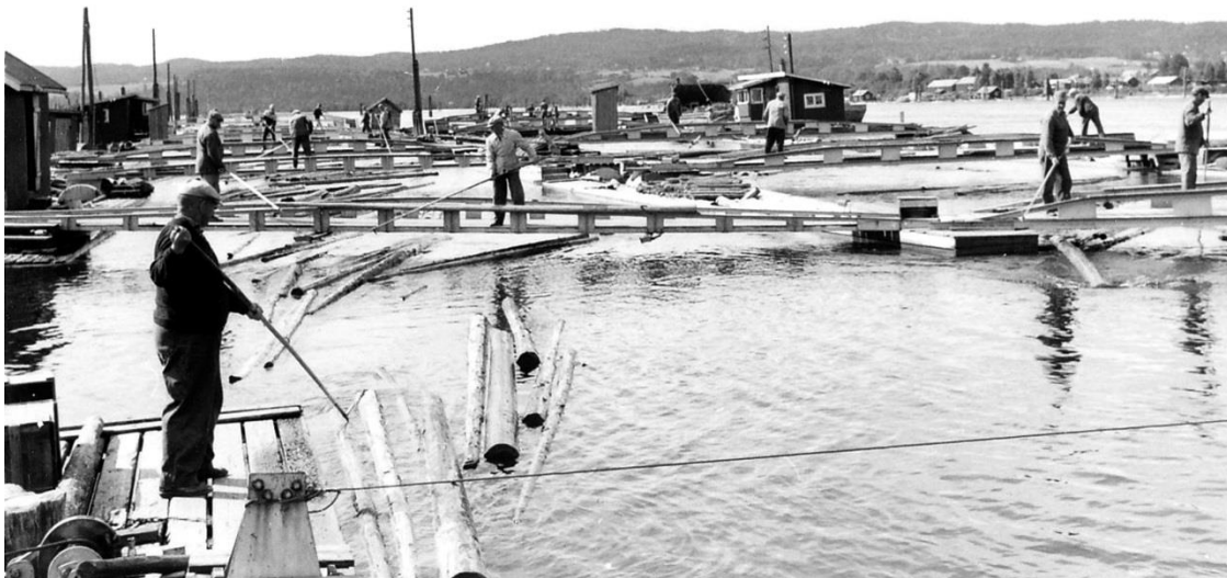
Fra det nye anlegget i 1960-årene. Bildet er av anlegget på østsiden.(foto: Per Emil Berg)
