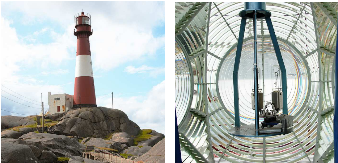
Figur 11.19: Eigerøy fyr er et mektig monument fra en tid før GPS gjorde sitt inntog. Til høyre: Lensesystemet som omkranser lyspæra er imponerende. Det er tre ekvivalente lensesystem som er plassert 90 grader på hverandre. Siste “veggen” er åpen slik at vi slipper inn til pæra. Lensesystemene er over to meter høye.
