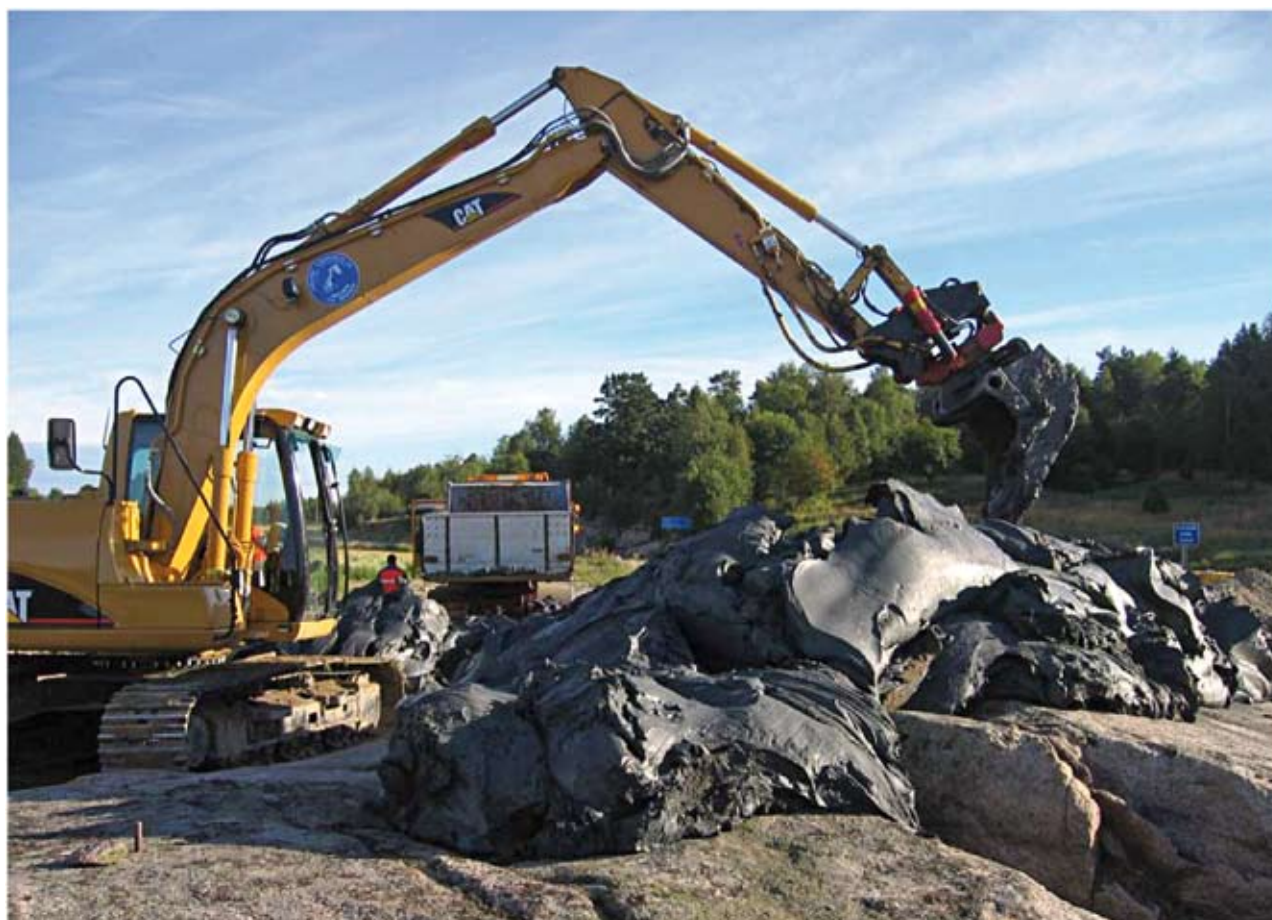
Figur 3_15: Det første lasset med plastisk leire vert lagt på Solberg nordre (lokalitet 27). Foto: Kristin Marie Berg.
