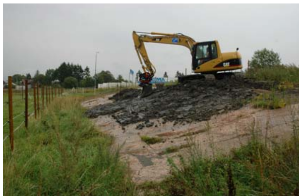
Figur 3_30: Lera läggs på berget på Alvim (lokal 55) i augusti 2005. Foto: Eva Ernfridsson.
