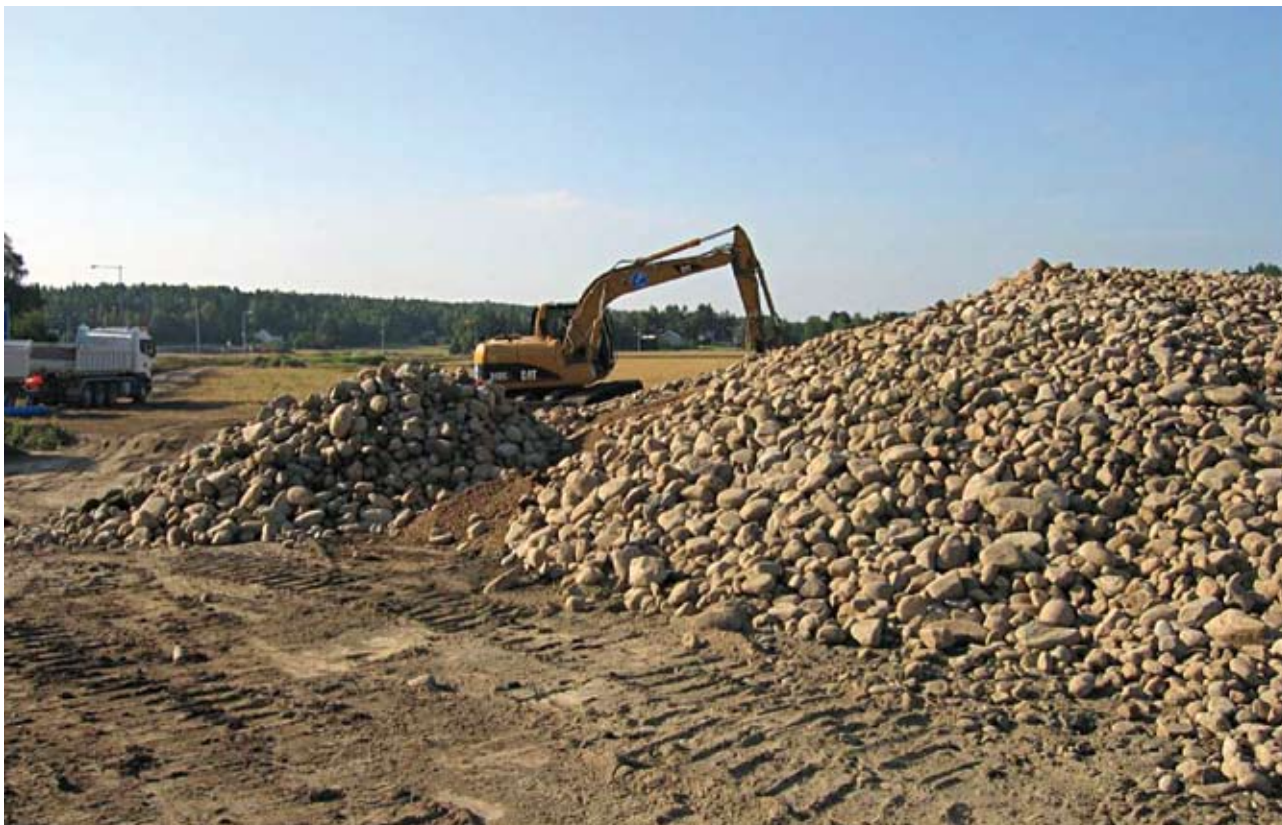
Figur 3_19: Det øvste laget med kulestein vert lagt på Solberg nordre (lokalitet 27). Under kan ein skimte natursingelen. Foto: Kristin Marie Berg.
