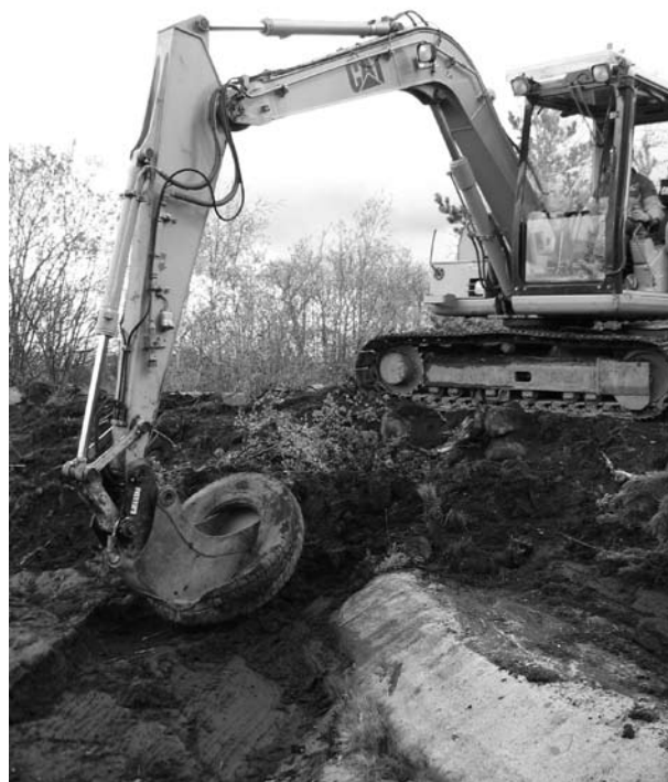
Figur 5_3: Maskinell avdekking av bergflater med potensial for funn av helleristninger på Årum nordre (lokalitet 41). Maskinfører er Tom Ridderseth. Foto: E6-prosjektet Østfold, Kulturhistorisk museum.
