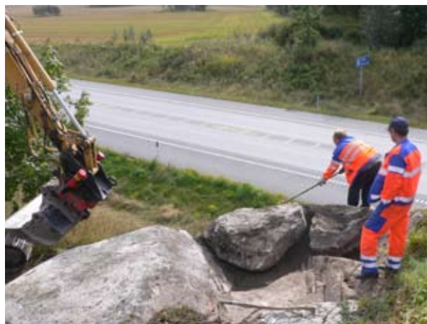
Figur 3_22: Stenbumlingar gjuts fast på den övre delen av Tungården (lokal 17) för att leran ska ligga kvar och inte glida ned på E6. Foto: E6-projektet Østfold, Kulturhistorisk museum.
