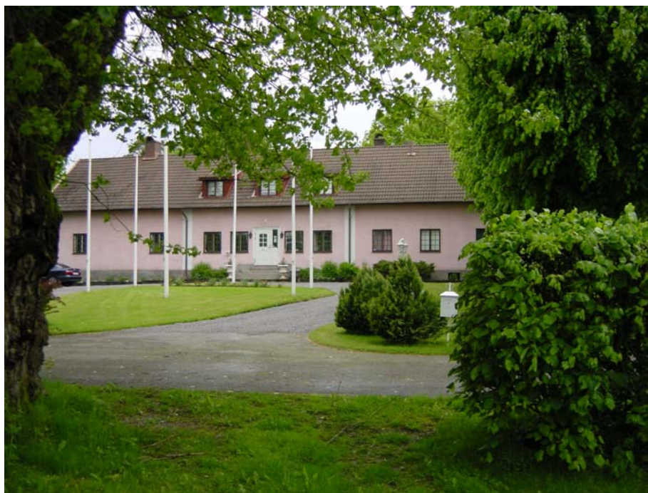
4. Rösan : Den Skandinaviske Storlosjen av Rosenkors-Ordenen A.M.O.R.C.s administrasjonsbygning i Onsala like sør for Göteborg.
