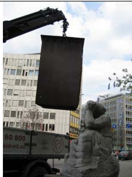
Bilde 10: Trekassen løftes av og på med kran.
