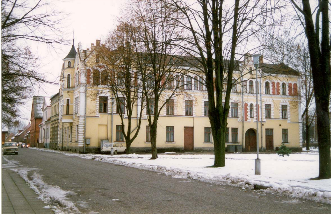
Hovedbygningen til Viljandi Kultuurikolledž i 1997.
