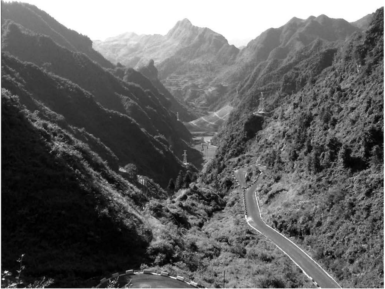
Figur 19. Den tildekkede slagghaugen i Dashuixi dalen. Fra punktet der bildet er tatt renner det en liten bekk der prøve "D1 opp" ble tatt. Bekken renner forbi slagghaugen lenger nede i dalen.
