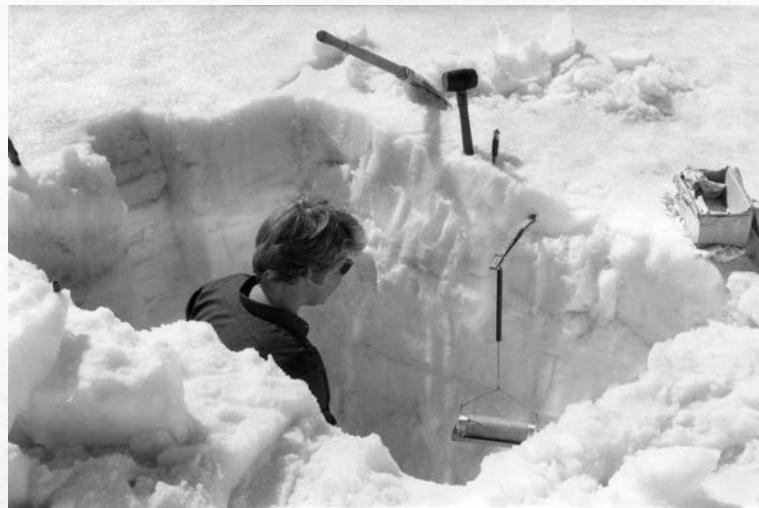
Snöpröven tas ut med en spesiell snöprövesylinder. Sylinderen med snöpröven i veies på en tarert fjærvekt.
