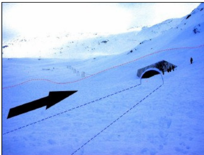
Figur 47: Skredet frå Sætreskardsfjellet 25 februar 2002. Vegen var sperra i 250 meters breidde, i tillegg gjekk skredet ca. 80 meter inn i tunnelen. Pila viser skredet si retning frå motsatt fjellside. Vegbana som er stipla inn vart dekt med 4 meter snø. Bak viser opninga av Oppljøstunnelen (Opphavleg foto: Elias Sperstad, Gudbrandsdølen Dagning)(Kristensen 2005).
