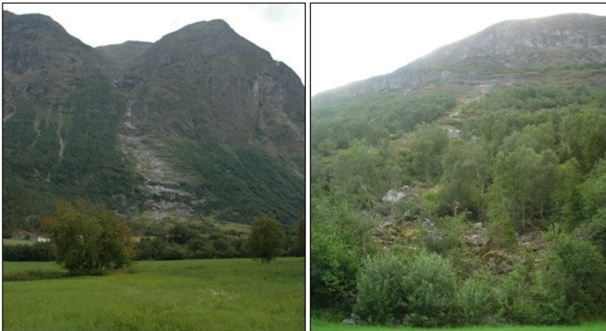
Figur 52: Til venstre: Skredsporet etter det årlege snøskredet Hjelleuksen. Til høgre: Spor etter et relativt fersk steinskred ned mot Bombeneset.
